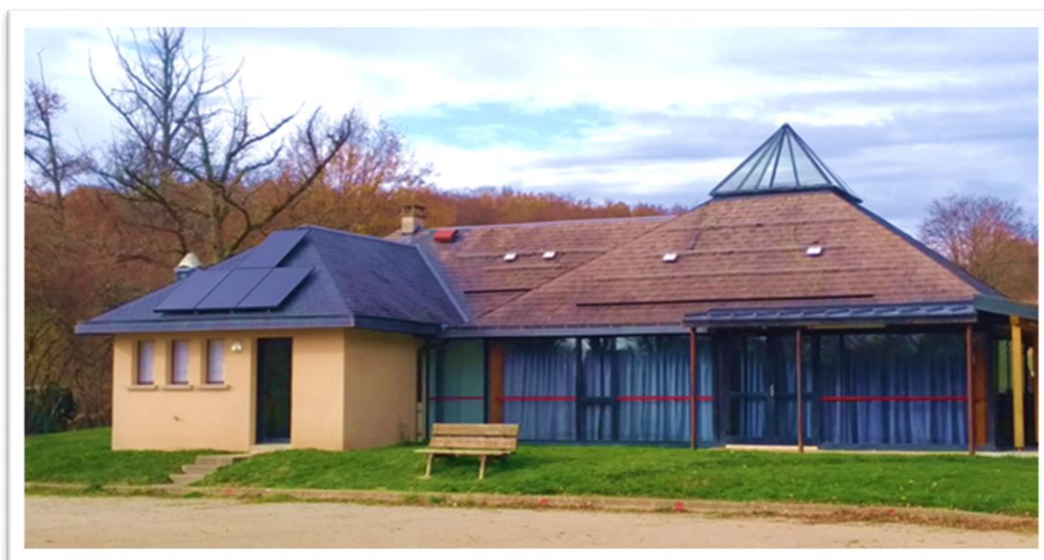
Installation en cours des panneaux photovoltaïques sur le toit de la salle polyvalente
